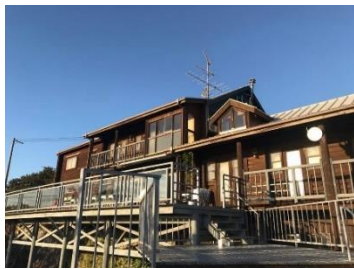
兵庫県淡路市 La Terrasse Awaji
